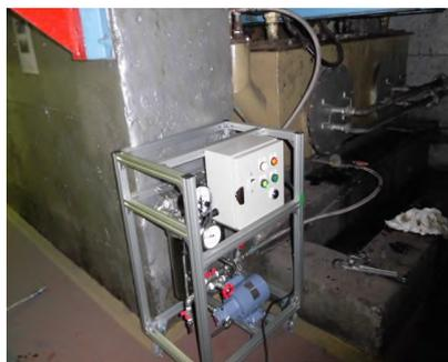
リン酸エステル油の油劣化により酸価が管理基準値を越えた状態となっていたが、**作動油浄化装置PEC**の常設運用により酸価は順調に低下。継続運転することで基準値以下まで酸価が改善。
