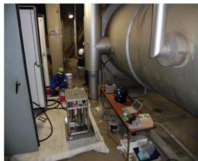
4日間要していた定検フラッシングが、**作動油浄化装置PEC**の仮設運用により1日間で終了。
