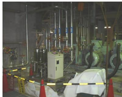
運転サイクル中の油劣化により限界管理値付近まで酸価が上昇したが、**作動油浄化装置PEC**の仮設運用により新油相当にまで酸価・汚染度・水分が改善。
