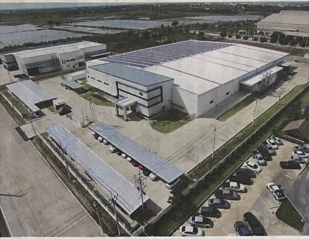
ECF社屋の外観
