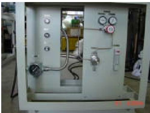
収納盤及び取付架台の下部構造には、減圧弁、フィルター、バルブなどが収納されております。
