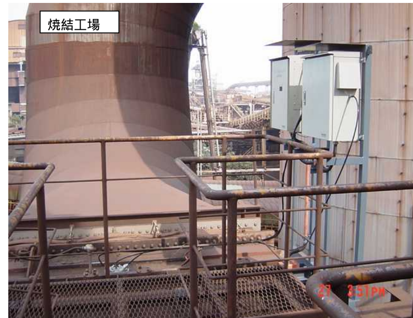
腐食性ガス雰囲気では保護カバーを設置
