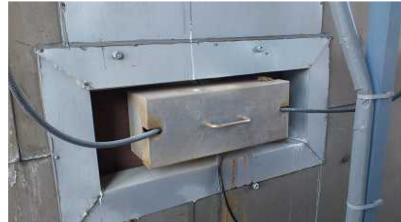
腐食性ガス雰囲気では保護カバーを設置
