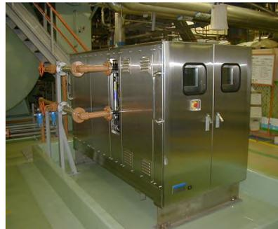
タービン油の劣化生成物による機械式ガバナ弁動作不具合が発生していたが、**静電浄油装置 OCM**の常設運用により解消。
