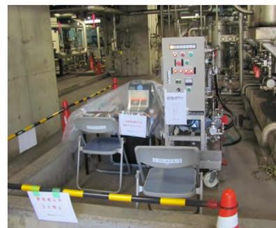
定検時に9日間要していた系統フラッシングが、**静電浄油装置 OCM**の仮設運用により4日間で終了。
