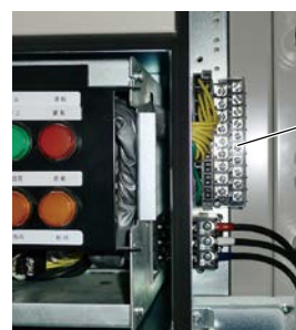
制御回路接続端子台
